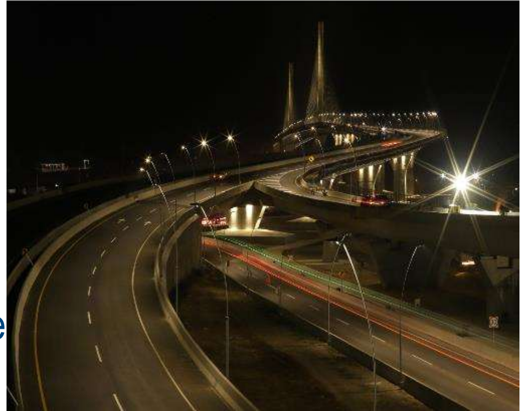
Pont de Pumarejo - Barranquilla - Colombie
